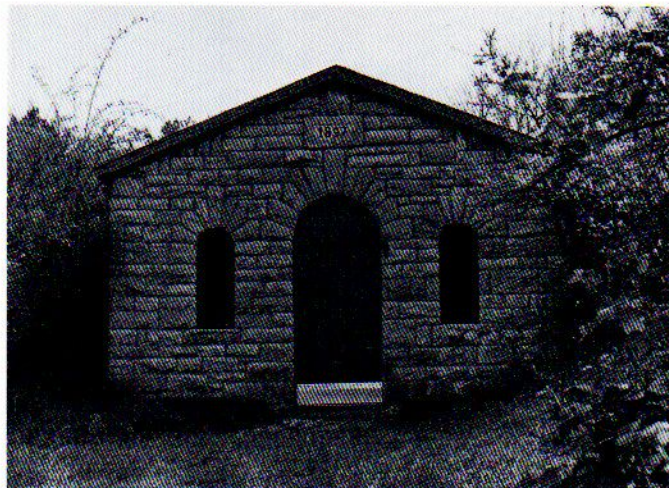
Wasserbehälter an der Alten Steige
