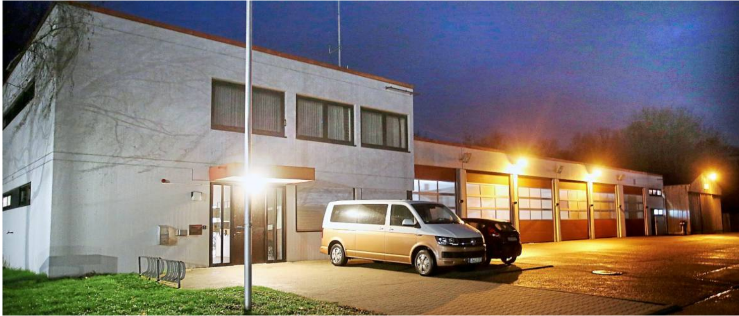
Das Besigheimer Feuerwehrhaus steht in den nächsten Jahren im Fokus von Stadt und Wehr. Eine Sanierung ist fällig.
